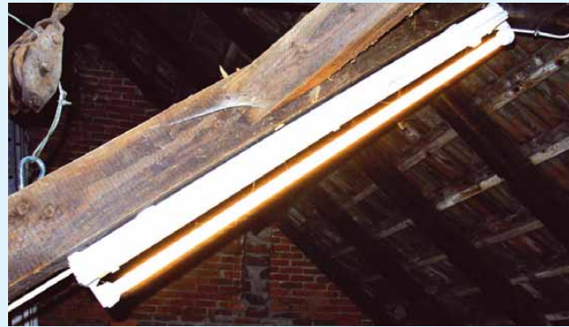
3 Falsch ausgewählte Leuchte – Schutzart IP 54 ist für Leuchte nicht erfüllt, da Leuchtstofflampe offen betrieben wird
