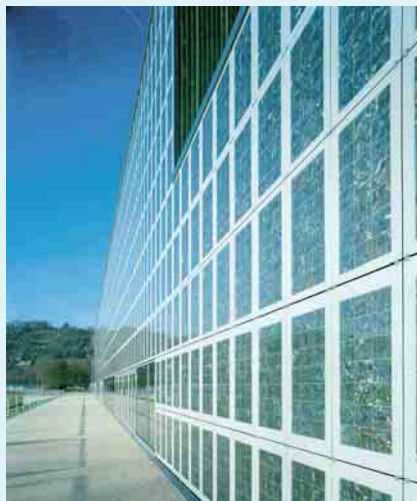
1 TüArena in Tübingen mit grün gefärbten, semitransparenten Solarzellen
