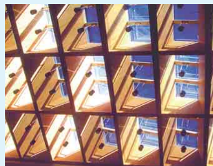
4 Oberlichter mit semitransparenten Dünnschichtzellen filtern das Tageslicht gleichmäßig
