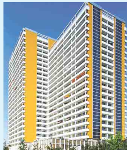
2 Südfassade mit einer 70 m hohen PV-Anlage
