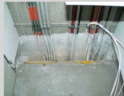
③ b) Mauerlaibung und Kabel mit Brandschutzfarbe beschichten
