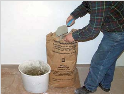
4 a) Mörtel entsprechend den Hersteller-vorschriften anrühren
