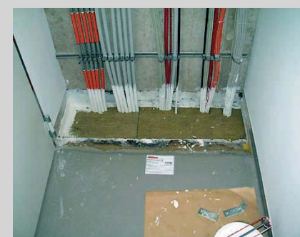
③ d) Bündig eingesetzte Mineralfaserplatten
