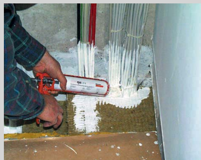
③ e) Löcher mit Mineralwolle (Plattenreste) dicht verschließen. Fugen und Zwickel mit Brandschutzspachtel ausfüllen (Pinsel oder Kartusche).
