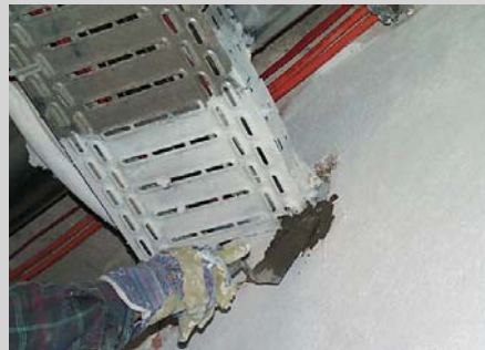
4 b) Mörtel ganzflächig und sauber ver-arbeiten
