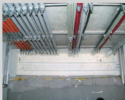
③ g) Kabelschotts in Decken mit einem mechanischen Belastungsschutz sichern
