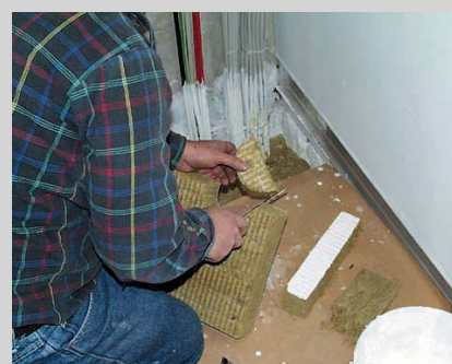
③ c) Mineralfaserplatten ausmessen und passend zurechtschneiden
