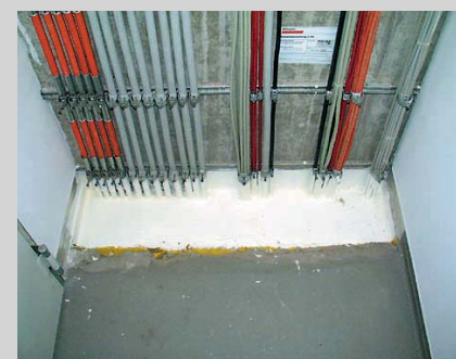
③ h) Kabel zu beiden Seiten des Schotts mit Brandschutzfarbe beschichten. Kennzeichnungsschild an einer Seite anbringen.
