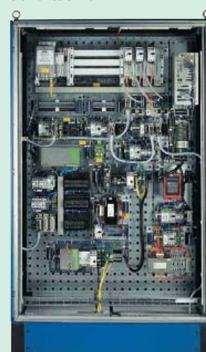
④ Konventioneller Schaltschrank mit einzelnen Komponenten
