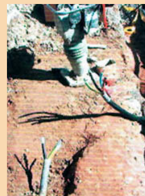
➊ Gespreizte Kabelenden der zu schließenden Ringleitung
