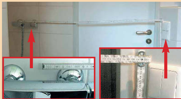
2 Einhaltung des Bereichs 1 bei einer Duschecke ohne Wanne
