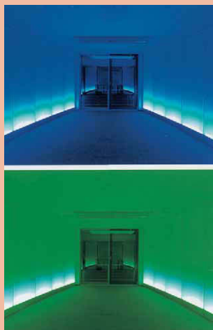
17 Systemwand WaVaria mit LED-Technik für variable Flächenfarben
