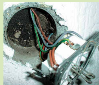
1 Installationsdose aus Metall
