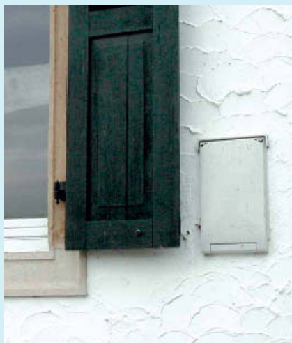
4 Hochgesetzter Hausanschlusskasten in Außenanschlusstechnik
