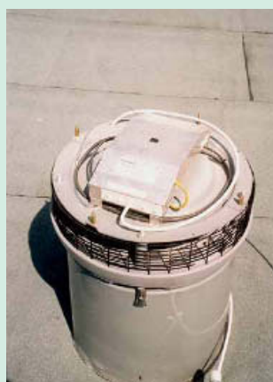
④ „Zugentlastung“ und Kabeleinführung
