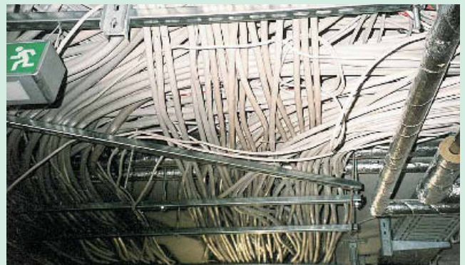
① „Sach- und fachgerechte“ Leitungsverlegung
