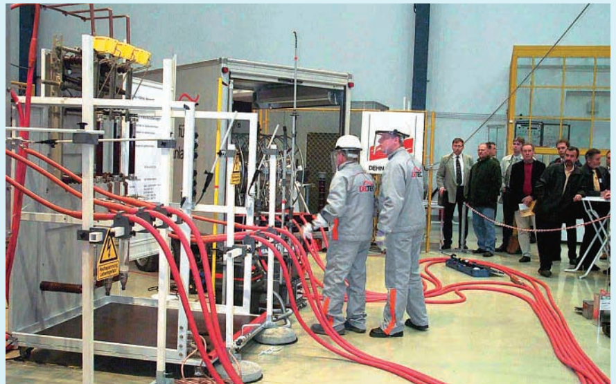
6 Mobile Überbrückungseinheit, fertig angeschlossen
