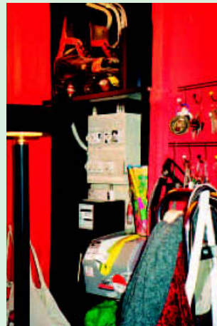
5 Verteiler mit „Garnierung“
