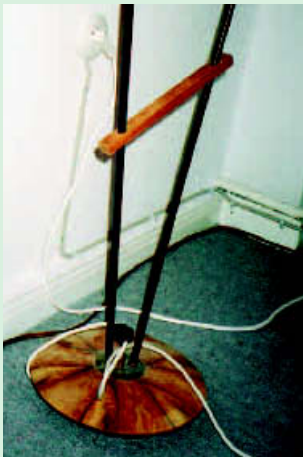
3 Endpunkt der neuen Leitung
