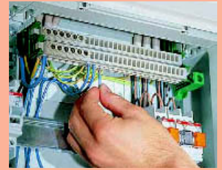
4 In Kooperation entwickelte N/PE-Quick-Steckschiene
