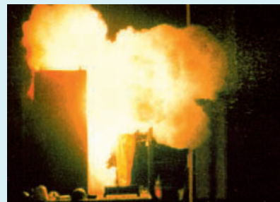
3 Lichtbogenprüfung in einem geöffneten NS-Schaltfeld, 726 V, 25 kA, 800 ms
