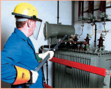
② Für das Reinigen von Mittelspannungs-Isolatoren und vergleichbare Arbeiten stehen erprobte AuS-Techniken zur Verfügung, die das Freischaltung entbehrlich werden lassen
