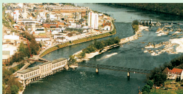
1 Gesamtansicht des Wasserkraftwerks Rheinfelden (links deutsches Ufer)
