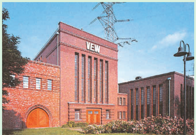
Museum „Strom und Leben“ im Umspannwerk Recklinghausen
