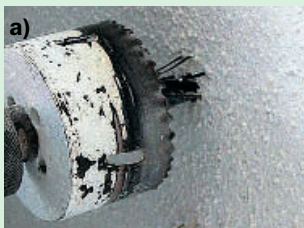
3 Kronenbohrer mit Bohrkronen zum Ausfräsen des Putzes und axialem Bohrer zur Zentrierung
