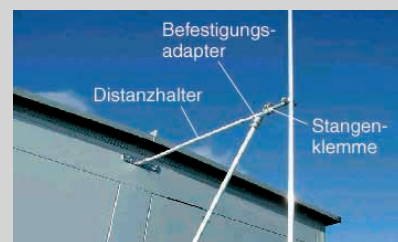
3 Systemlösung DEHNiso® für isolierte Fangeinrichtung
