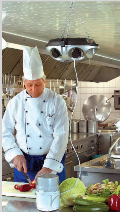
➊ Abgehängte Kombinationen wie z. B. das Produkt AirKRAFT mit verschiedenen Steckdosen und integrierter Absicherung halten den Arbeitsbereich beispielsweise in der Küche oder im Buffetbereich frei von störenden Leitungen.
