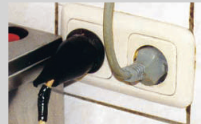
1 Gummistecker sind für die Küche ungeeignet, da Gummi und Fett sich nicht vertragen. Solche Stecker sind lebensgefährlich und müssen sofort ausgetauscht werden.
