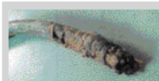
❶ Zerstörtes Kabelende nach dem Lichtbogenunfall
