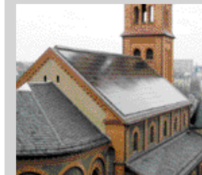
② 220 Module des 24,64 kW p liefernden Solargenerators auf dem Süddach der Herz-Jesu-Kirche in Plauen fügen sich harmonisch in das architektonische Ensemble – eine von weit mehr als 100 Kirchen in Deutschland, deren Dächer umweltfreundlich Strom liefern
