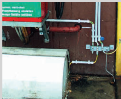
7 Wesentlich für den inneren Blitzschutz sind Potentialausgleichmaßnahmen
