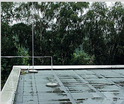
④ Sichere Zuleitungsverlegung
