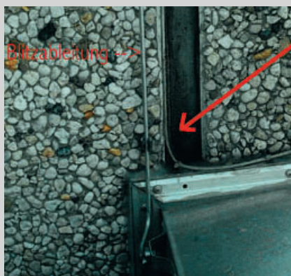
1 Eine Näherung zwischen Datenleitung und Blitzableiter führte zur Zerstörung einer Leiterplatte der Brandmeldeanlage
