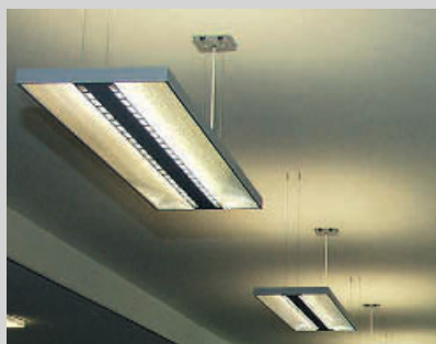
7 Flachleuchten von Spectral sorgen für die vorgeschriebene Helligkeit und Blendfreiheit
