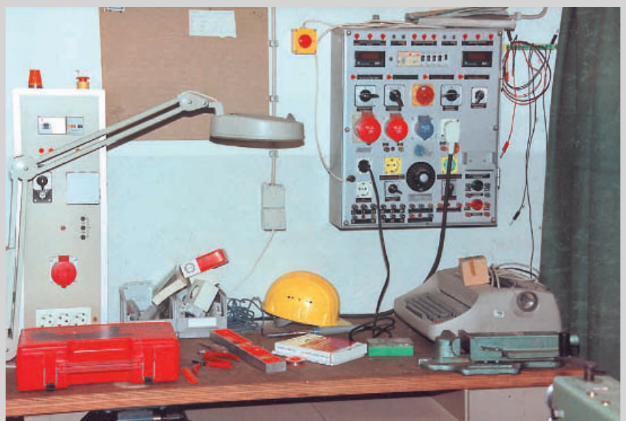
1 Werkstattprüfplatz mit stationärer Prüfsäule (links) und Prüftafel (rechts)
