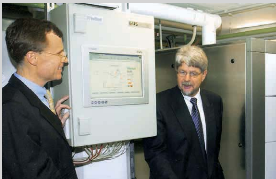
4 Inbetriebnahme des ersten BZ-Heizgerätes 4,6 kWel von Vaillant mit Energiemanager im Vordergrund. Parallel dazu steuert er an anderer Stelle auch 1-kW-Heizgeräte von Sulzer Hexis. Quelle: Vaillant
