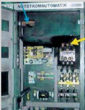
❶ Mit einem Rollbandmaß wurden die Anschlussklemmen des Leistungsschützes rechts im Schaltschrank überbrückt
