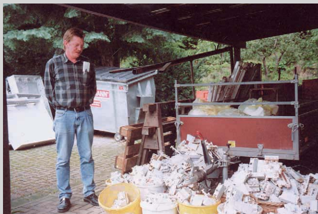
③ Alle durch Wasser geschädigten Reiheneinbaugeräte hat Elektromeister Gunter Göhler aus Freital ausgemustert
