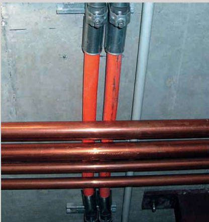
4 Eine simple Lösung ist die Verlegung der Leitungen mit Funktionserhalt direkt unter der Decke.
