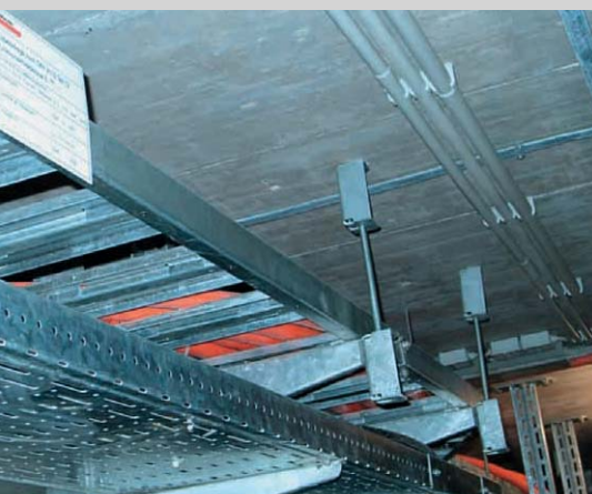
1 Eine nach DIN 6280 Teil 13 errichtete Kabelanlage, die einer äußeren Brandeinwirkung 90 Minuten lang standhält.
