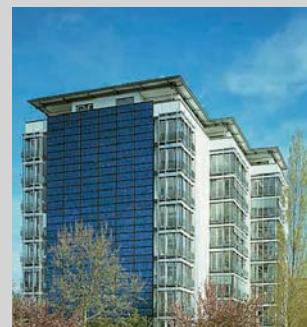
② In Südrichtung ausgerichtete Fassade mit Solarmodulen 190 x 70 cm 2 ; 230 m 2 liefern ca. 13,5 kW. Quelle: FVHF
