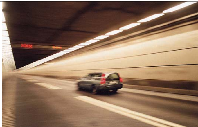
1 Beleuchtung im Öresundtunnel
