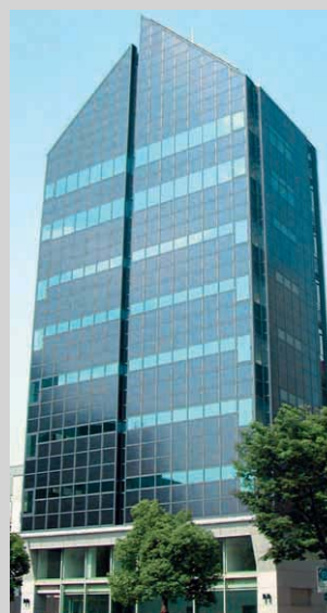
6 Auch in Kobe City (Japan) wurden Gebäudefassaden mit teils dreieckförmigen PV-Modulen aus Dresden bestückt (ca. 1000 m 2 mit 78,3 kW). Quelle: Solarwatt
