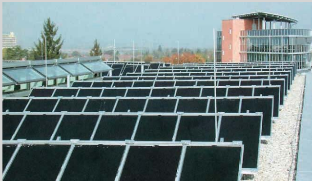
3 Eine der zwei bereits 2001 errichteten Anlagen mit CIS-Modulen mit einer Gesamtleistung von 17 kW Quelle: Würth Solar
