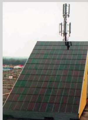
4 Ungerahmtes Glaslaminat kann Dachziegel ersetzen. Gerahmte CdTe-Module können auch als konventionelle Aufdachlösung montiert werden Quelle: Antec
