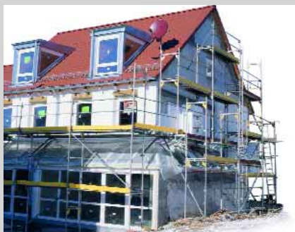
6 Außenwanddämmung bei Mauerwerksbauweise
