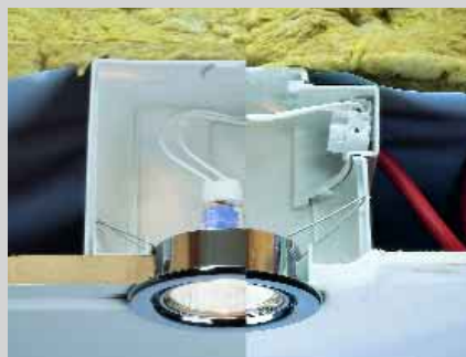
12 Dichte Übergänge durch Verbindungsstutzen
