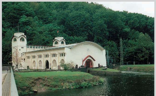
① Wasserkraftwerk Heimbach
