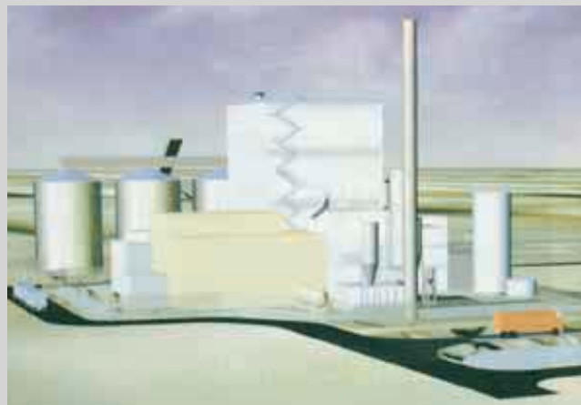
② Grafik des in Königswusterhausen im Aufbau begriffenen Biomassekraftwerks der 20-MW-Klasse. 200000 t Holz pro Jahr liefern eine Brennstoffleistung von 100 MW. Die thermische Leistung beträgt 60 M. Quelle: MMV
