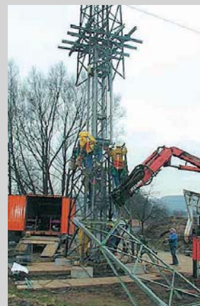
3 Erhöhung eines 110-kV-Mastes unter Spannung
