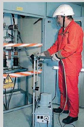
1 Nachfüllen von Endverschlüssen unter Spannung
