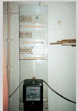
① Alte Installation etwa aus den 20er Jahren, noch betriebsfähig, solange sie nicht bewegt oder voll belastet wird
