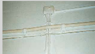
① Alte Installation etwa aus den 20er Jahren, noch betriebsfähig, solange sie nicht bewegt oder voll belastet wird
