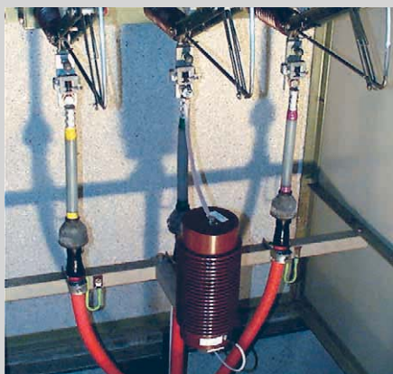
② Beispiel einer freilufttauglichen kapazitiven Ankoppelung (CDC)
