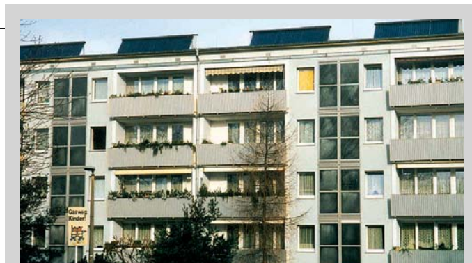
1 Sanierungsbeispiel in Berlin-Friedrichshagen. Nach ersten Messungen wurde der jährliche Heizenergiebedarf von bisher 195 kWh/m 2 auf Werte zwischen 70 bis 85 kWh/m 2 reduziert.
