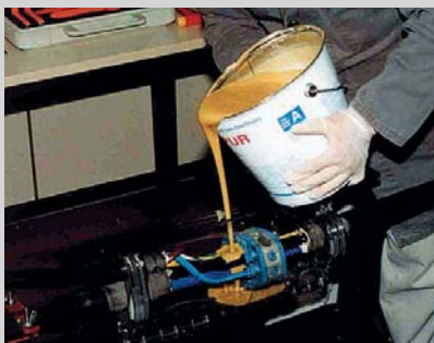
8 Nach Einbau der Muffenschalen wird im letzten Arbeitsgang die Muffe vergossen.
