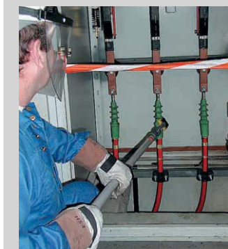
3 Feuchtreinigung von Kabelendverschlüssen
