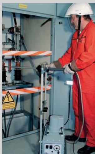
4 Nachfüllen von Massekabelendverschlüssen
