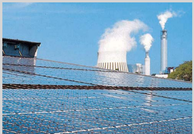
2 170-kW p -PV-Anlage in Berlin-Spandau – realisiert auf den Lagerhallen eines Handwerksbetriebes
