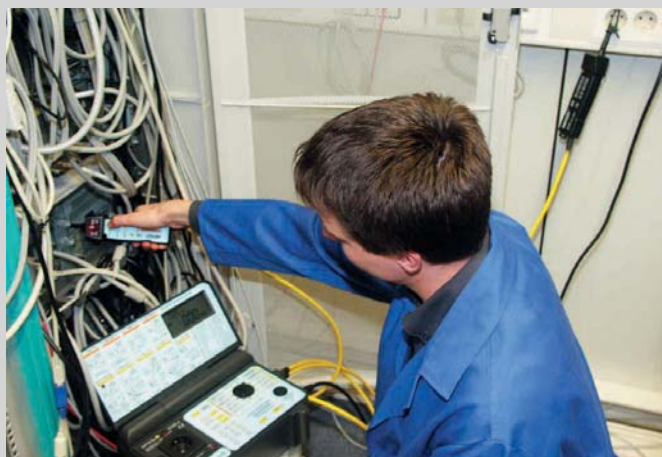
2 Messung des Berührungsstromes mit dem MACHINEmaster gegen eine benachbarte Steckdose
