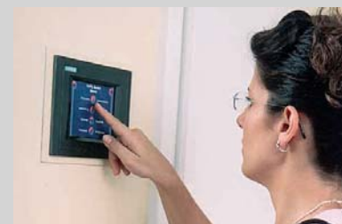
3 „Technik-Box“ mit Touchscreen – per Touch wird Licht zentral geschaltet oder die Alarmanlage aktiviert. Der Mieter wird über den Gerätestatus informiert
