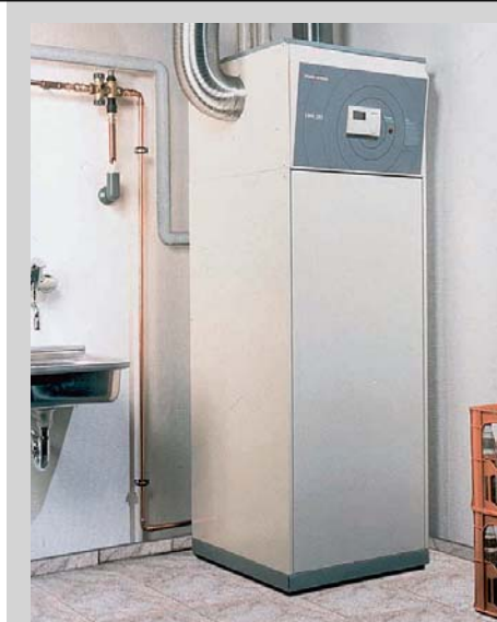
② Wärmepumpen und Wohnungslüftungsanlagen mit Wärmerückgewinnung gehören durch die neuen Vorschriften zu den bevorzugt einzubauenden ökologisch und wirtschaftlichen Systemen
