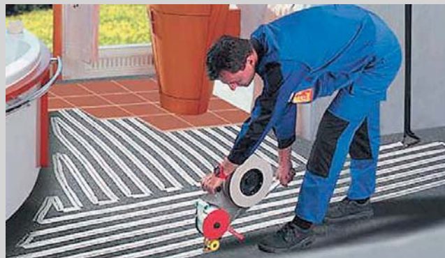
❶ Abrollbare oberflächennahe Fußbodenheizung (Foto: H. Rock GmbH)
