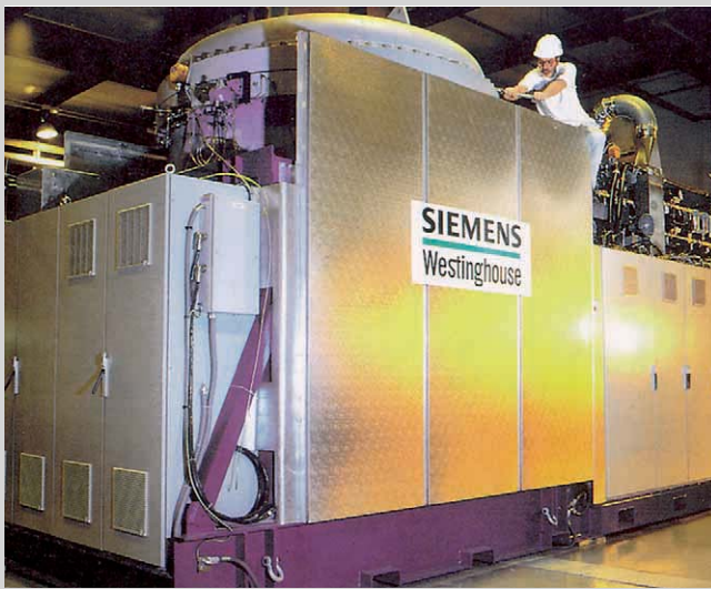
7 Das SOFC-Hybrid-system für 220 kW arbeitet mit nachgeschalteter Turbine (ähnlich wie die MCFC). 21 kW leistet ein Heißgasturbosatz, der Abwärme und Druckunterschiede ausnutzt. Die Wirkungsgrade erhöhen sich leistungsabhängig (bei späteren Typen für 2 bis 3 MW voraussichtlich auf 70 %)
