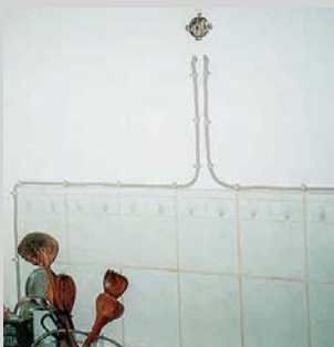
① Installation einer Steckdosenleitung – Baujahr 2001
