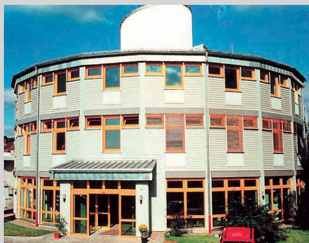
2 Passivhaus mit Saisonspeicher von 85000 Liter Volumen
