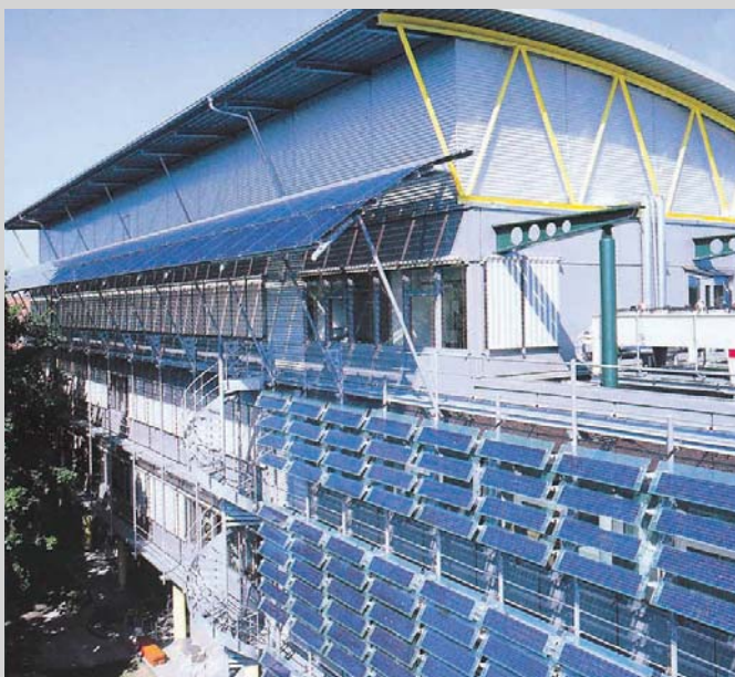
④ Das abgesetzte Vordach im hinteren Gebäudeteil enthält eine starre „Solarmarkise“ aus 126 PV-Modulen (Gesamtfläche 226 m 2 ). Im nicht verschatteten Vorderteil werden 140 PV-Zellen bestückte Glaslamellen einachsrig dem Sonnenstand nachgeführt.
