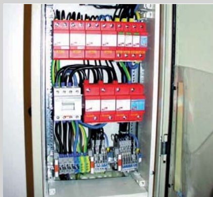
4 Blitz- und Überspannungsschutz mit Einzelkomponenten und separater Entkopplungsdrossel
